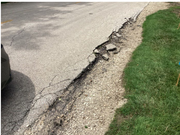
Pavement edge raveling
