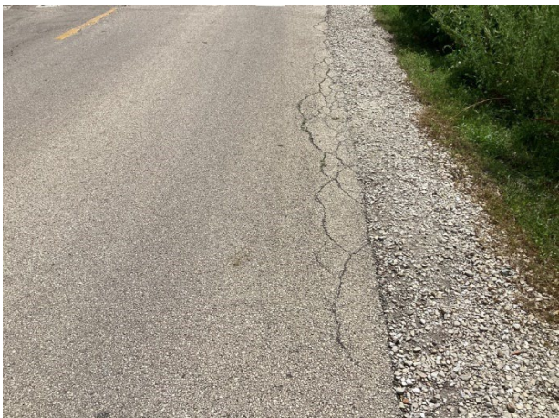
Edge cracks
